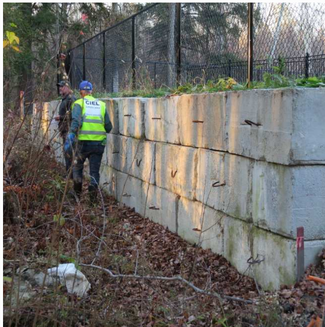
Remblai retenu par des blocs de béton sur une hauteur dépassant les 1.5 mètres à la limite de la RN. Photo JML 3 nov. 2022.
